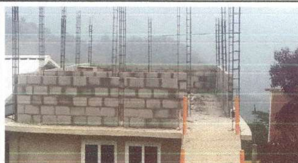
Foto 2. Levantamiento de pared en un 50%, previo a fundición de solera.
