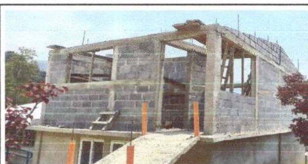
Foto 5: Terminado de mojnete de aula y dirección.
