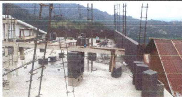
Foto 1. Inicio del trabajo de remozamiento para la construcción de un aula y dirección del centro educativo.
