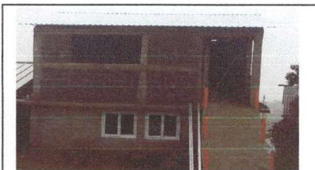
Foto 6. En esta fotografía se observa la construcción del aula y dirección con su respectivo techado, quedando pendiente la colocación de ventanas y puertas.
