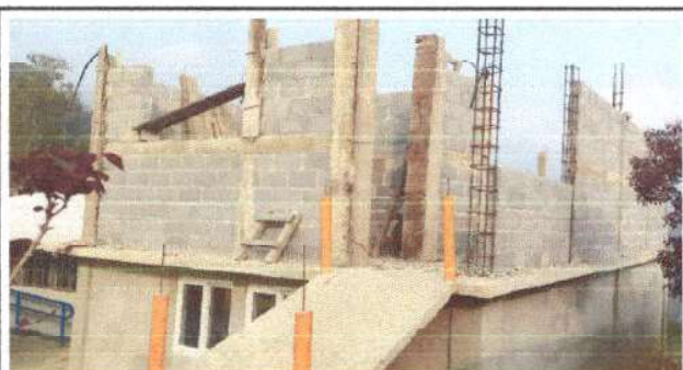
Foto 3. En esta imagen se observan los adelantos en cuanto al levantamiento de la pared y la fundición de columnas.
