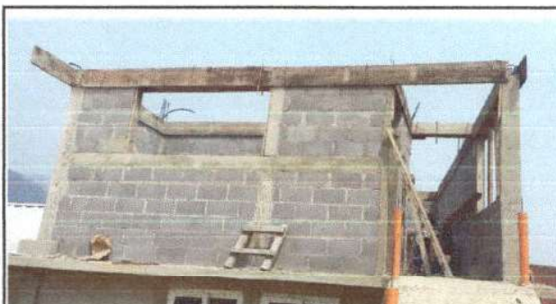
Foto 4. Se observa paredes construidas en un 100% y la fundición de soleras.
